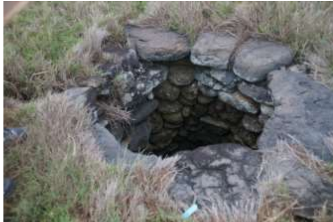
照片 4-2-6：西吉嶼南側階地菜園的水井，井口以玄武岩環疊
