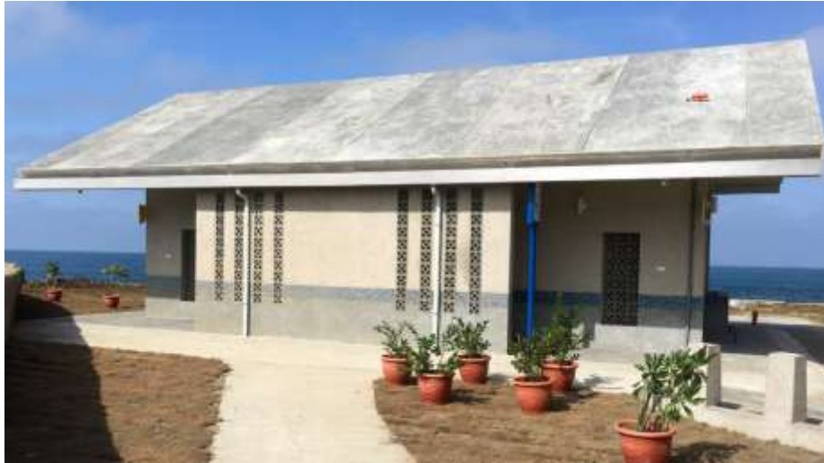
照片 2-3-8：東嶼坪公廁
