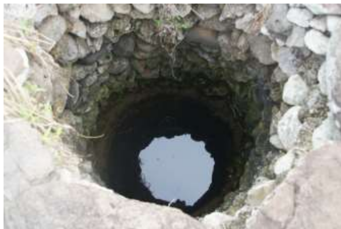
照片 4-2-7：西吉嶼菜園的水井，底層井壁為岩層，上層井壁以玄武岩砌築
