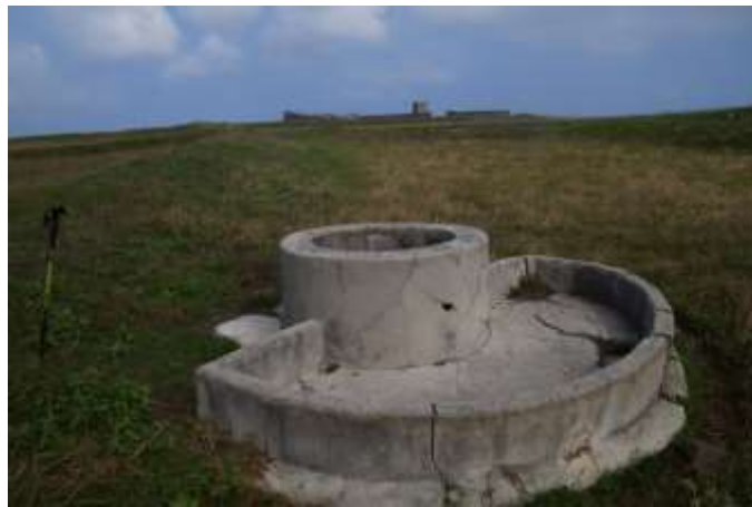
照片 4-2-1：兵厝西側的水井，有半圓形井盤
